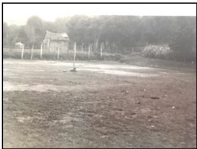
Figura 2 – Fundos do prédio do Grupo Escolar Jansen (1958)
