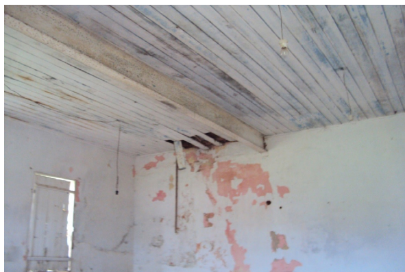
Figura 5 – Interior da escola
