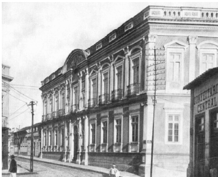
Figura 2 – Prédio do Ateneu Rio-Grandense/Escola Normal (1872)
